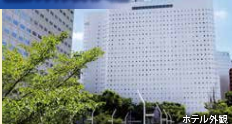
新宿ワシントンホテル・本館
